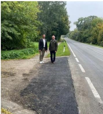
Aufgrund der zahlreichen Schlaglöcher bei der Straßeneinfahrt in der KG Rohrau zum Tennisplatz wurde eine neue Verschleißschicht aufgebracht.
